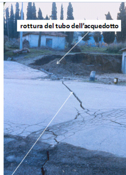
Flumeri: spostamenti verticali e rottura di manufatti
