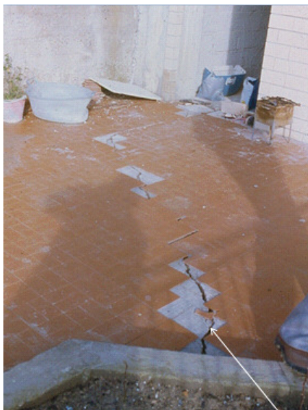
Flumeri: spostamenti verticali e rottura di manufatti
